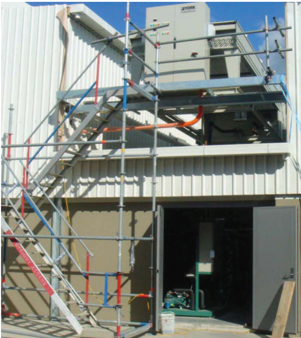
Схема 35 Холодильная камера, работающая на пропилене, установленная на крыше, и блок CO 2 , установленный в помещении под ней, при вводе в эксплуатацию.
