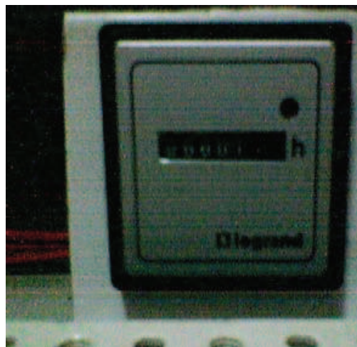
Схемы 4 и 5: Установлен монитор –датчик кВт-час и датчик эксплуатационных часов, Модель Йорк системы охлаждения воздухом: YDAJ98MU7-50PA
