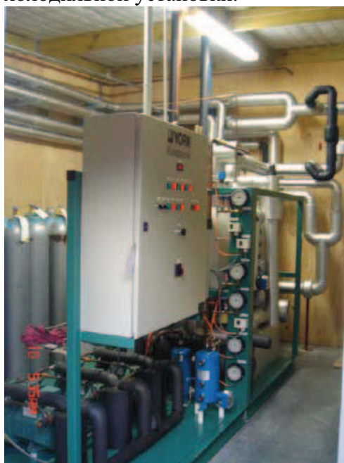
Схема 36 Часть установки, работающей на CO 2 , и несколько баллонов с CO 2 на заднем плане.
